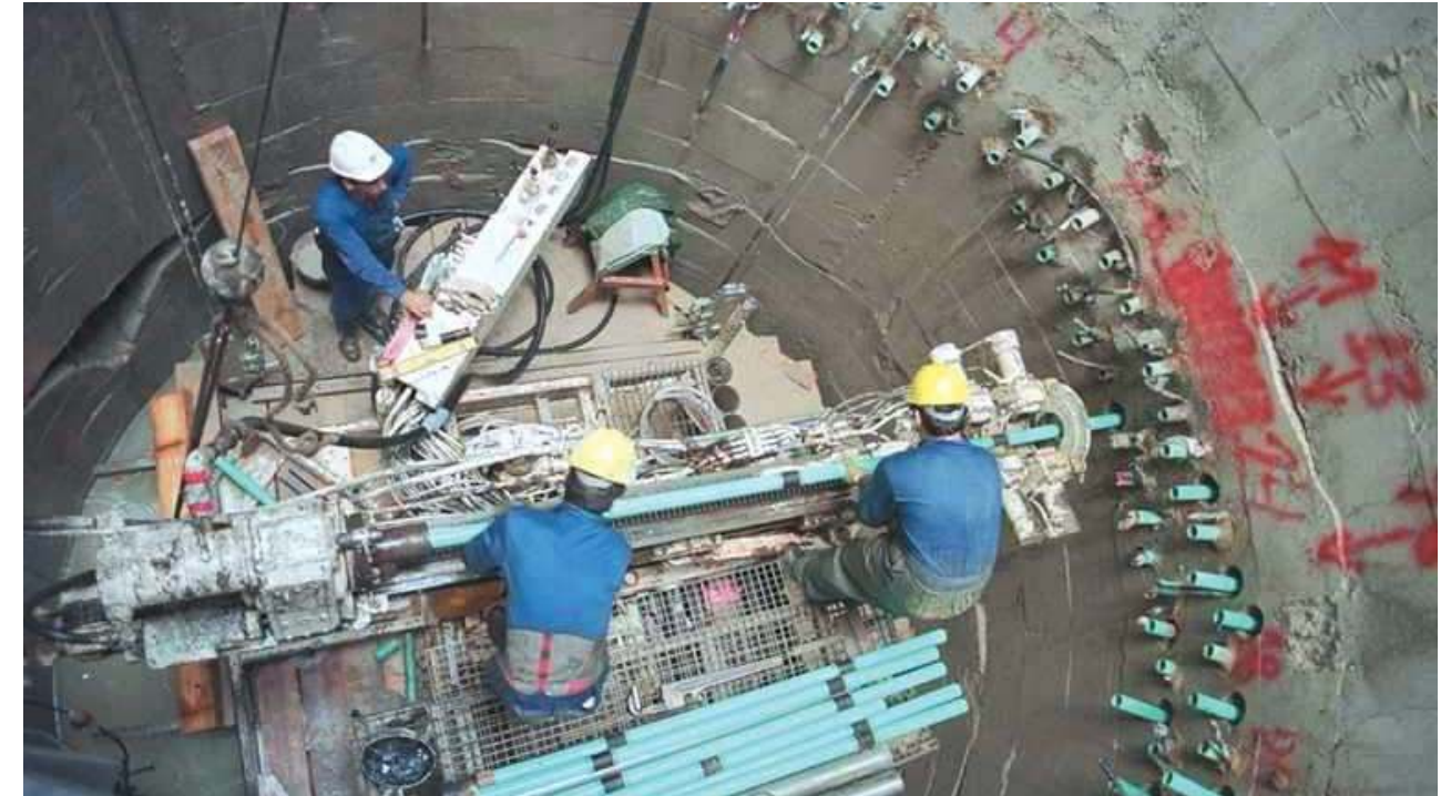
Figura 9 – Inyecciones con tubos manguitos desde pozo de tratamiento.
