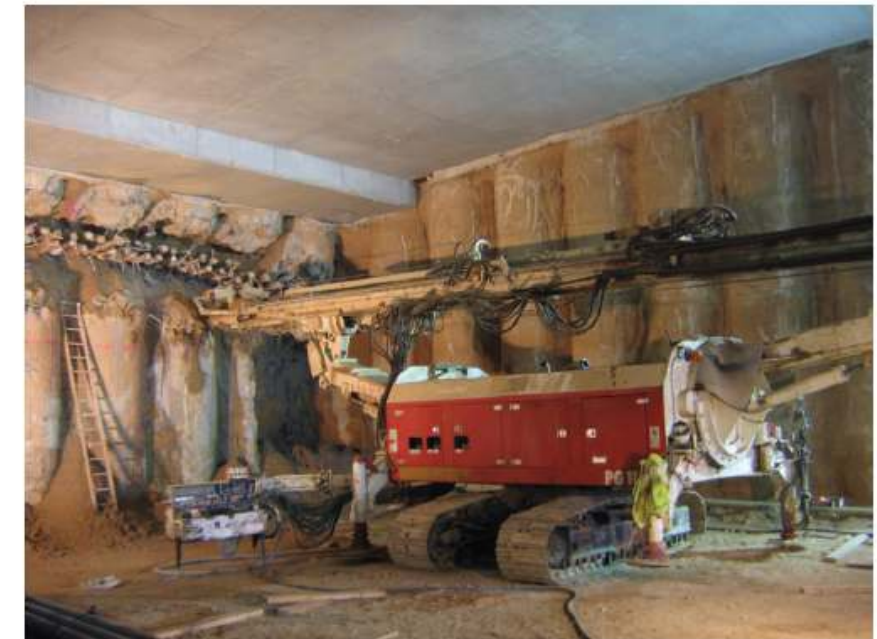
Figura 14 - Instalación del paraguas de micropilotes bajo Línea 1.
