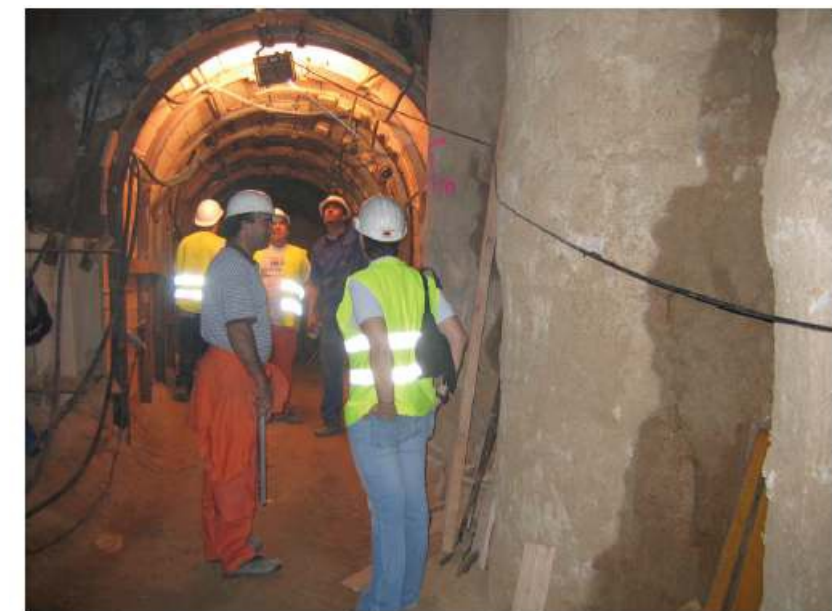
Figura 15 - Galerías hastiales por Método Alemán.
